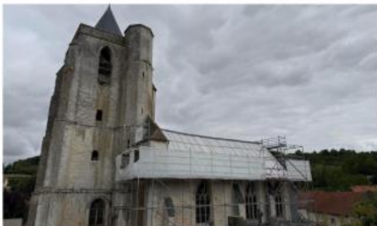
Le retour des échafaudages à l'église.
